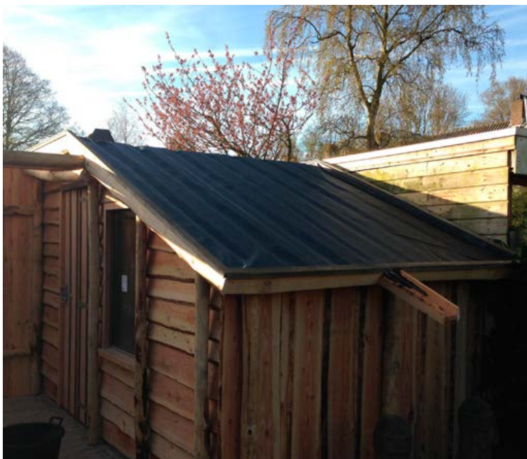
Je ziet meteen het verschil. Het kale dak versus een sedumdak.
