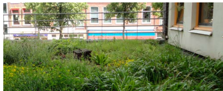
Schaduwnatuurdak op hoofdkantoor Stadsontwikkeling Zuiderdiep in Groningen.
